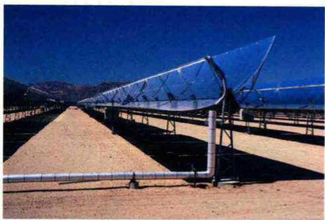
图5.20 加利福尼亚州达盖特 (Daggett) 附近莫哈维沙漠太阳能热电厂的抛物线型槽反光片。该设备利用太阳能生产水蒸气发电。抛物线反光片由计算机引导追踪日光, 把太阳能聚焦到充满换热液体的钢管上。(© Cameramann International)
