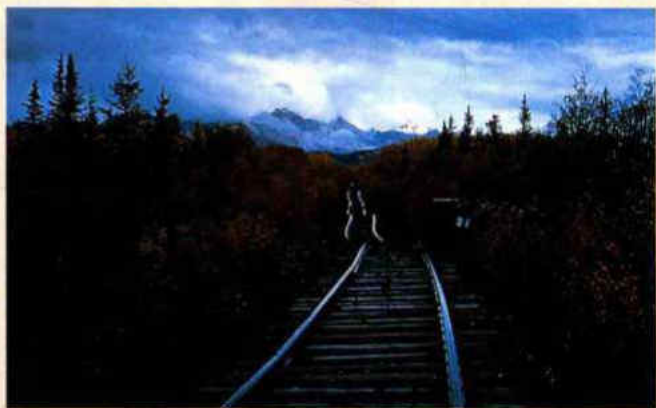
(b) 阿拉斯加铁路线受多年冻土融化的影响而发生挠曲。(© O. J. Ferrains / U.S. Geological Survey / L. A. Yehle photo)
