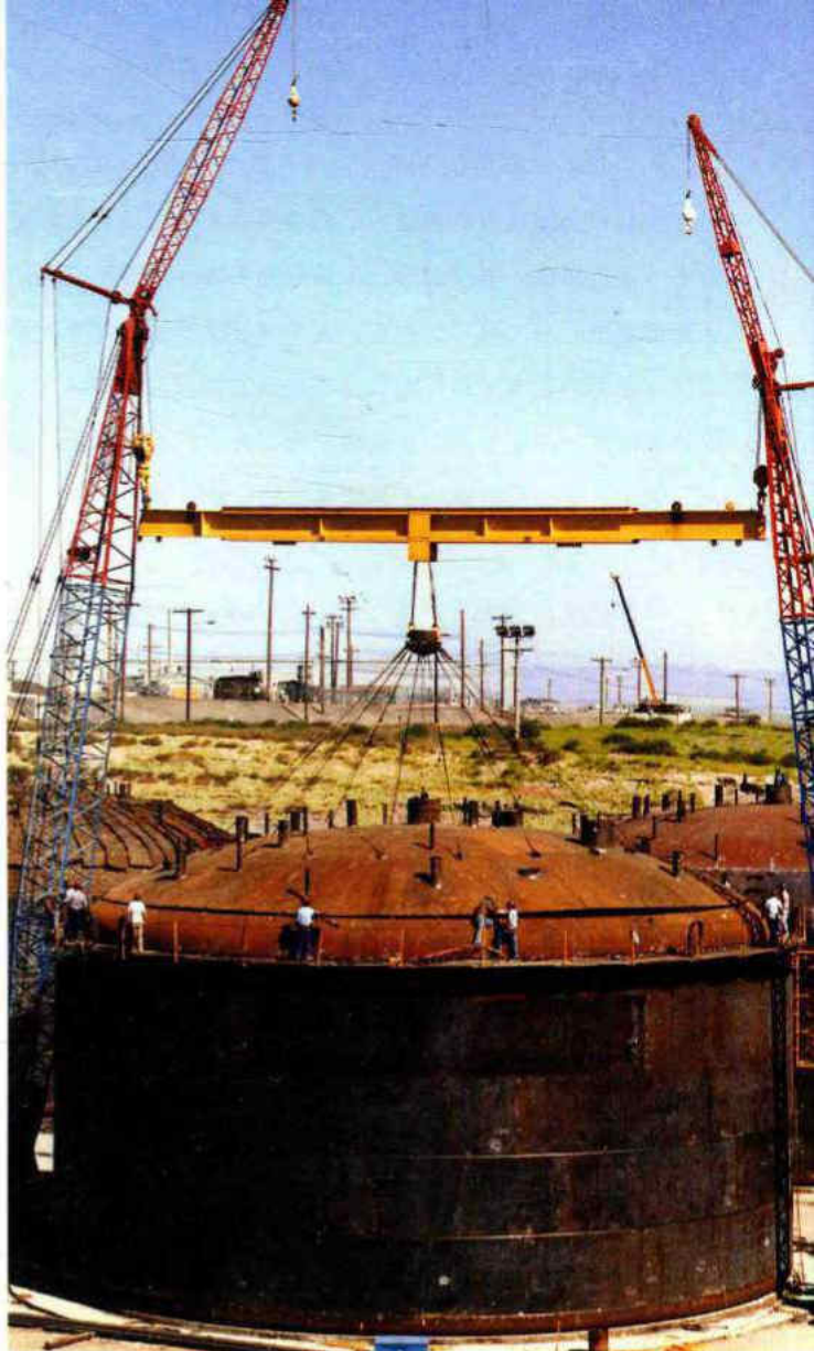
图12.30 华盛顿州汉福德在建的大储罐。1943—1985年间建造此类储罐保存来自汉福德原子能保留地高水平放射性废物,照片中的大储罐——有些容量达11亿加仑(编注:1美制加仑约为3.79升)——用混凝土包住后埋入地下。迄至20世纪90年代初,177个地下储罐中已知有66个发生渗漏。这些储罐保存的约5500万加仑废物中,大约有100万加仑液体已渗入土壤中,增加了对于放射性废物已经影响地下水源和流向哥伦比亚河的忧虑。
